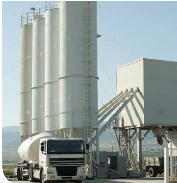
Anlieferung des Kunststoffgranulats und Befüllung der Silos mittels pneumatischer Förderung
